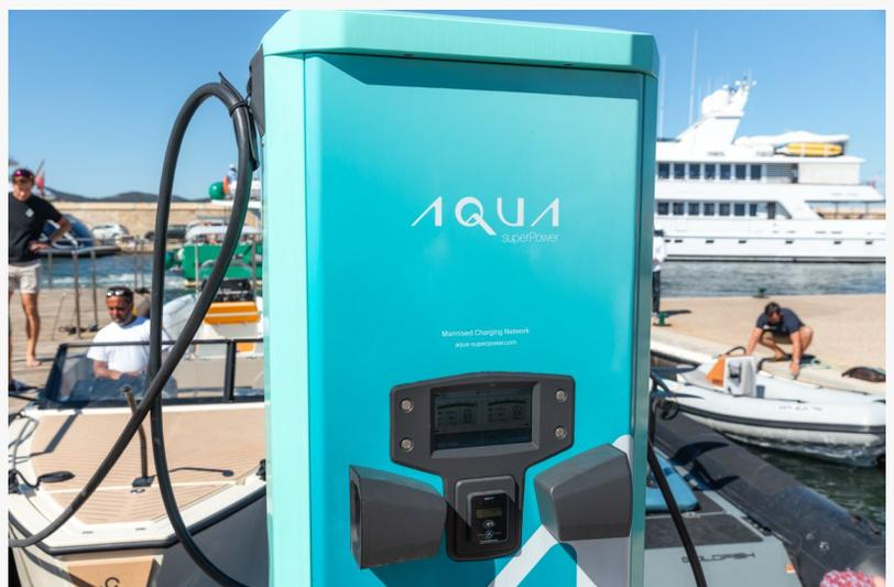
L'Aqua 75 en configuration double CCS au Port de Saint-Tropez suralimentant 2 bateaux électriques simultanément
